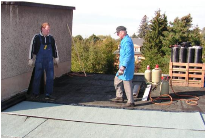
Tatkräftige Helfer bei der Abdichtung des neuen Lagerdachs
